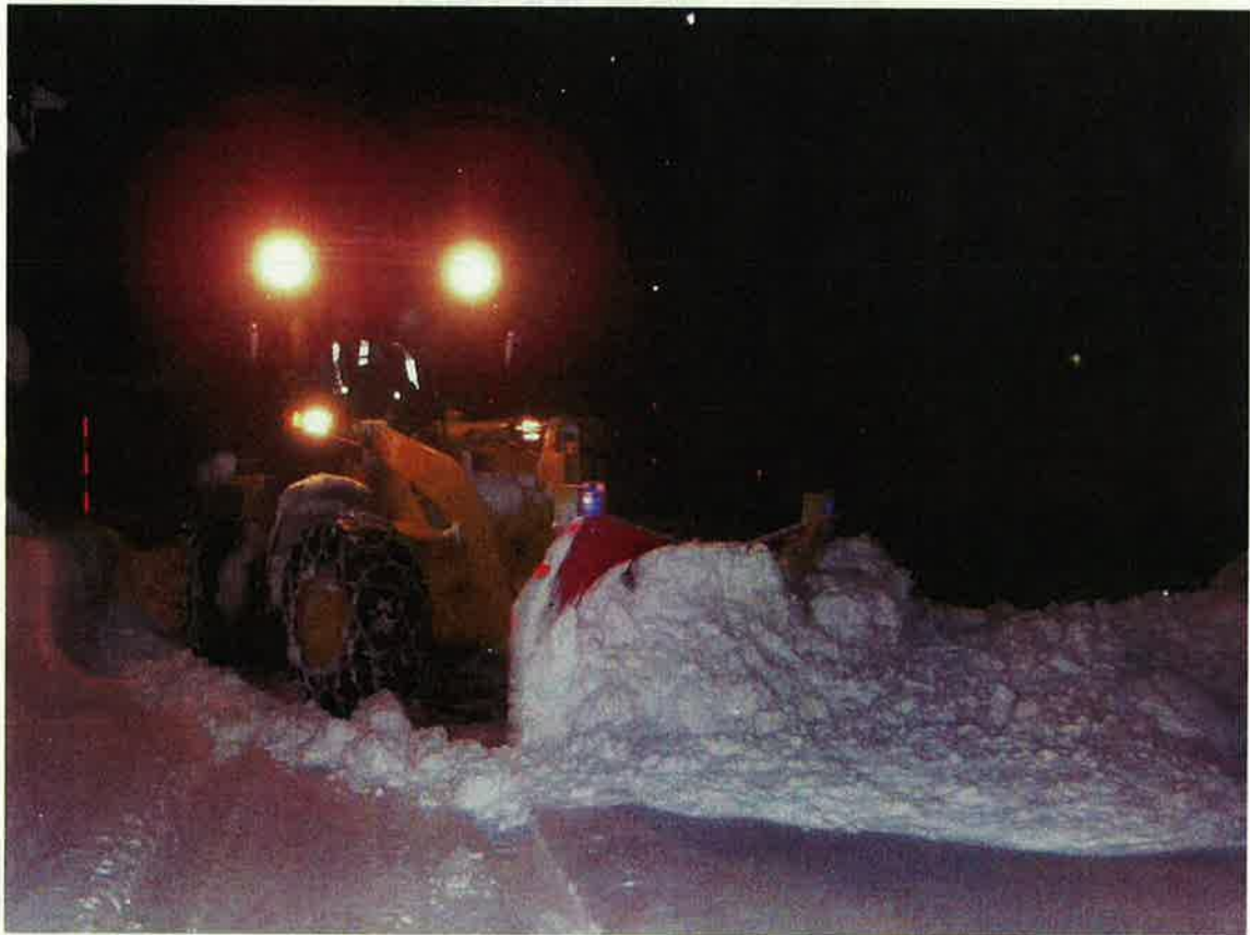
夜間の除雪作業（湯沢町）
