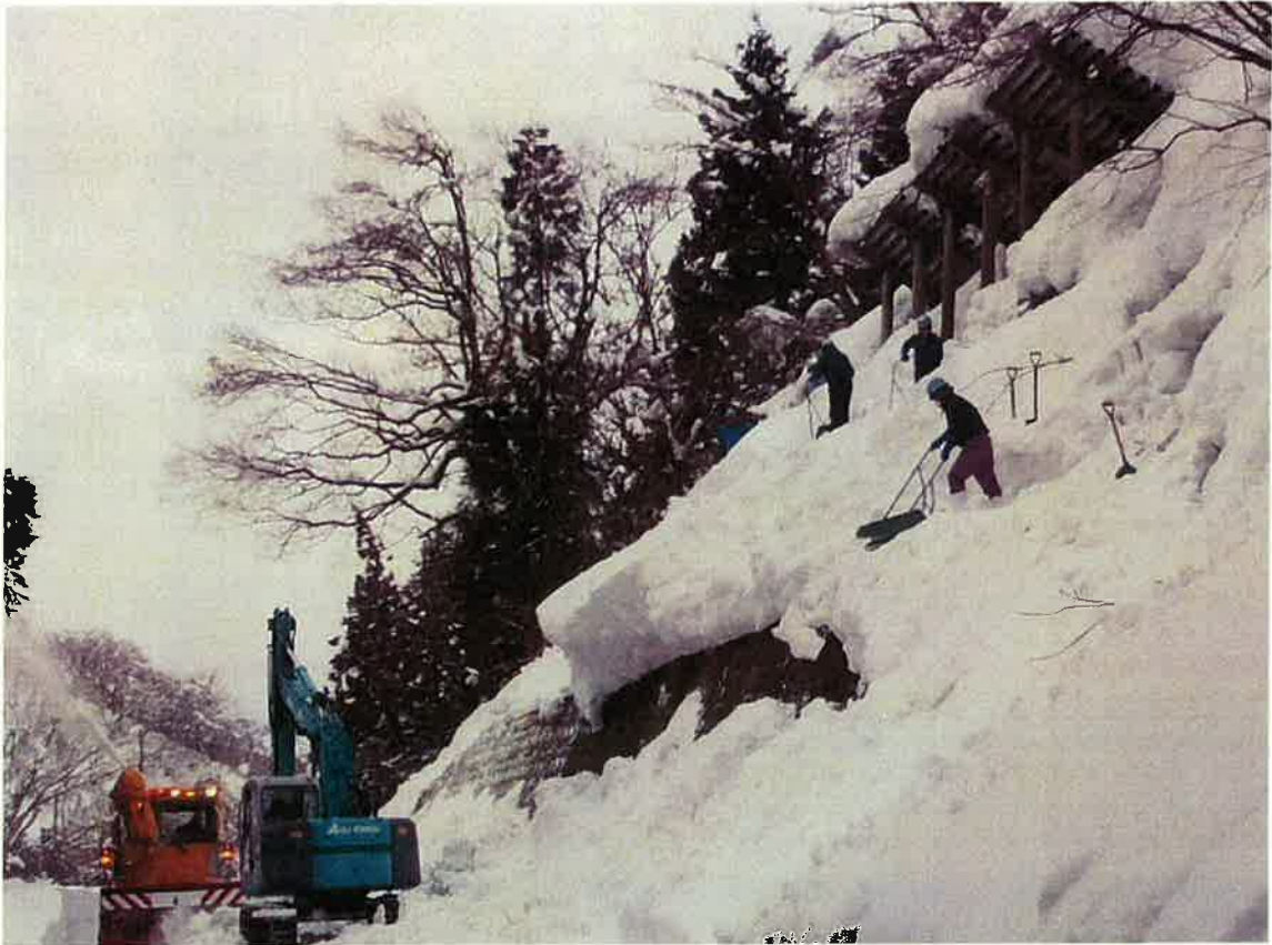
雪庇処理工（上越市）
