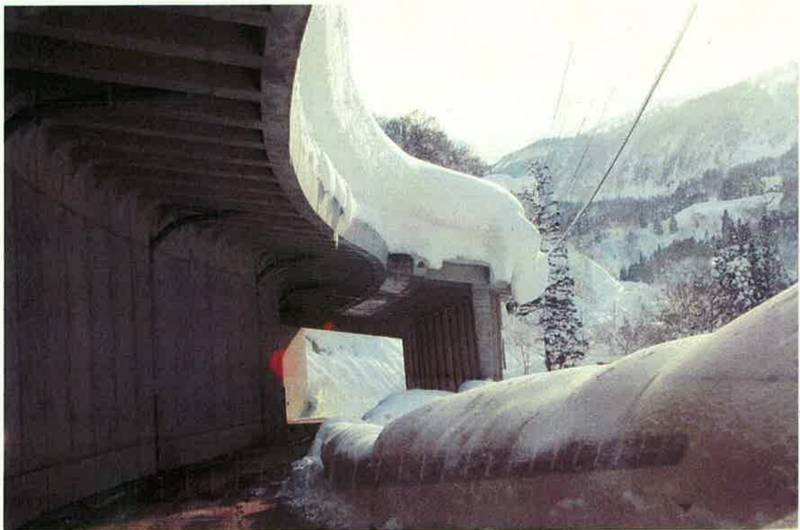
スノーシェッドの状況（津南町）
