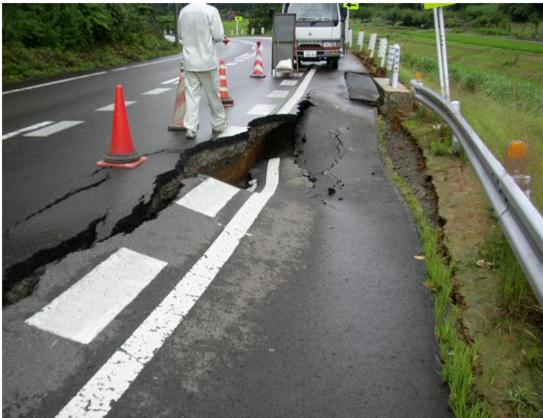
国道291号 柏崎市武石トンネル手前
